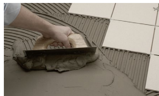
Aplicación del adhesivo. Adhesive material application.
